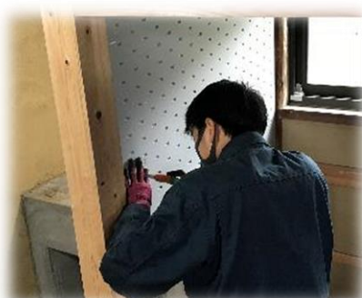
スイッチボックスを取り付ける 穴を開けています。
