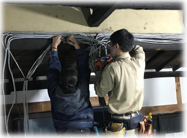
結線作業を行いました。誤結線がないように慎重に作業です。この作業で本日は終了です。
