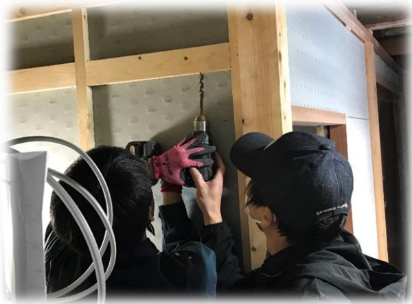
ケーブルを通すための穴を開けています。
