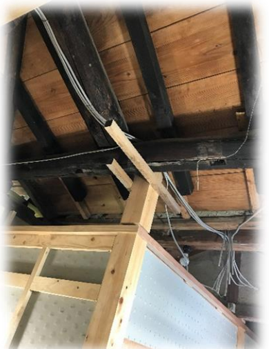
実際に通したケーブル
