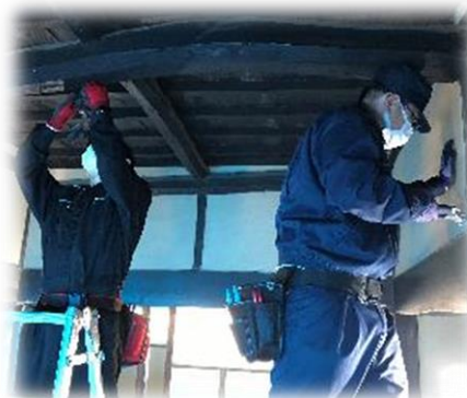
競技で行うような露出配線工事です。
