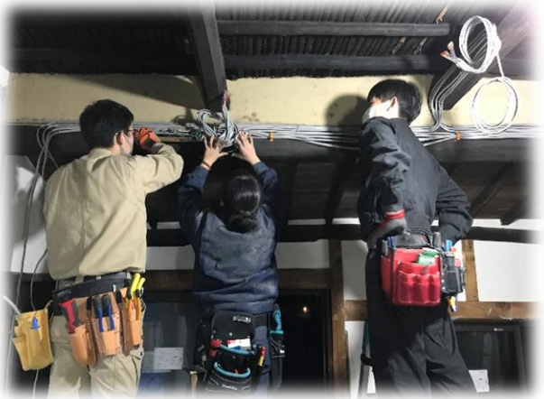
結線作業を行いました。誤結線がないように慎重に作業です。この作業で本日は終了です。
