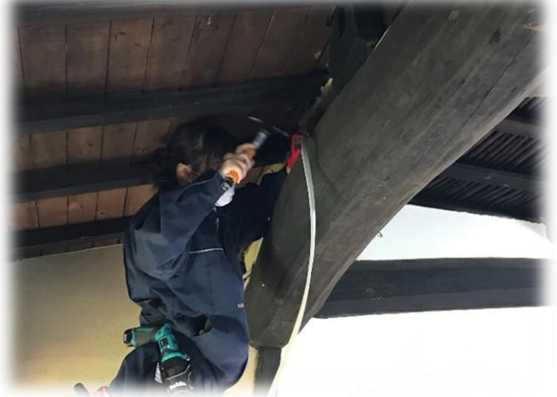
浮き蛇行のないように、ケーブル工事を行いました。
