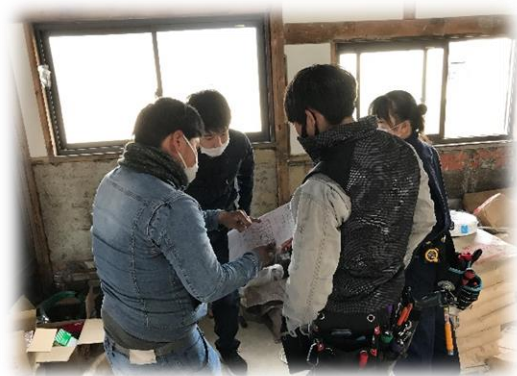
まず、配線図を見て作業の確認を行いました。
