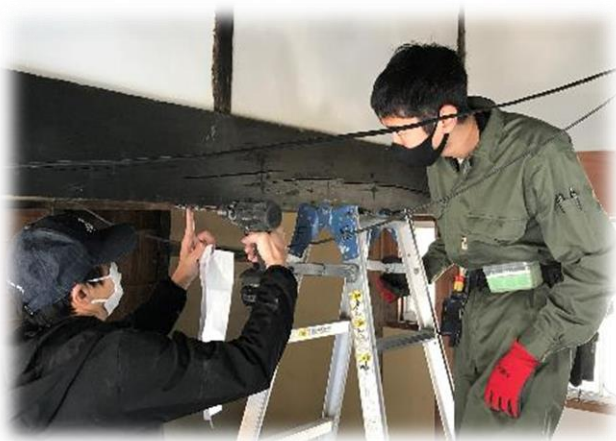
土壁に穴を開ける方法の説明を受けています。失敗すると、土壁の塗り直しになってしまうので真剣です。
