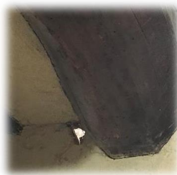
ケーブルを通す穴を土壁に開けました。
