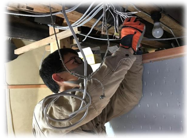
誤結線のないように、慎重に作業を行います。
