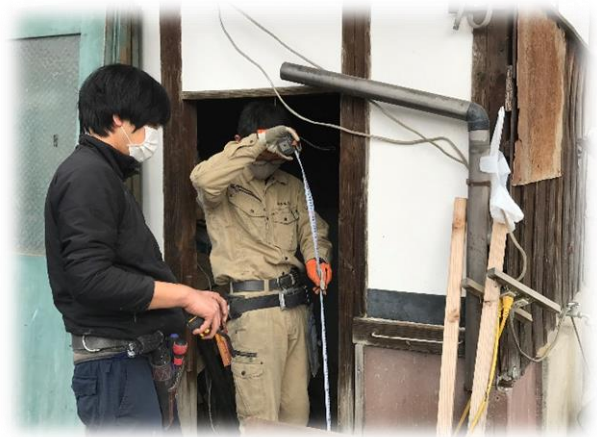
防雨コンセントを取り付ける位置を確認しています。
